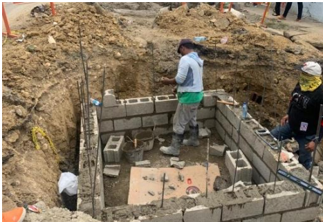
Construcción de registro pluvial calle Imbert.
