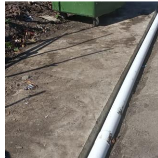
Construcción de rampas de acceso a contenedores.
