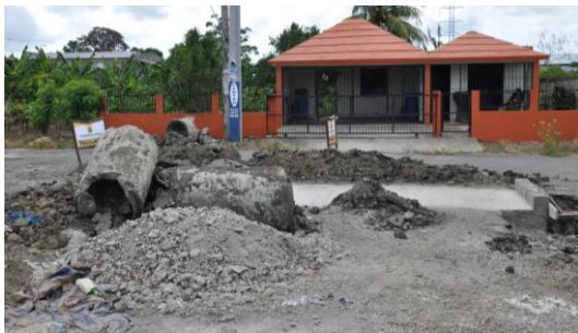
Construcción de badén.
