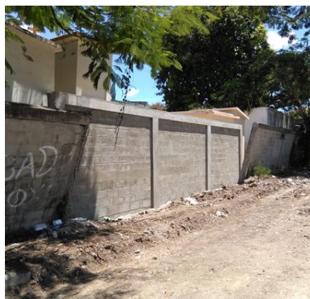
Construcción de 10.30 metros lineales de verja en el Cementerio Municipal.
