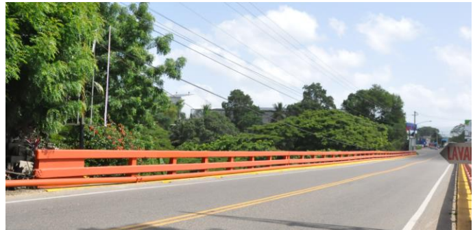
Puente de la Autopista Ramón Cáceres, sobre el río Licey.
