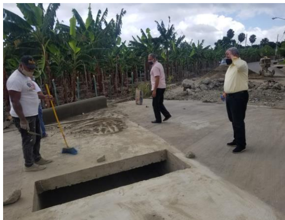
Supervisión del proceso de terminación del puente cajón en La Isleta.
