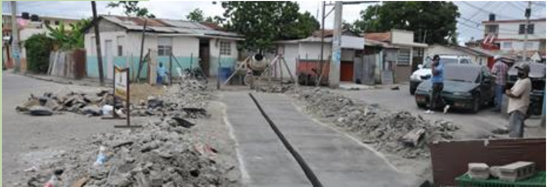
Construcción del solicitado badén de la calle José María Rodríguez entrada Las Flores, era un reclamo permanente de los vecinos y conductores en la parte alta de la ciudad.
