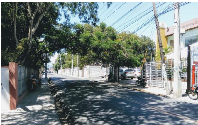
Bacheo con asfalto caliente en la calle Duarte, desde la Junta Central electoral hasta Guaucí.
