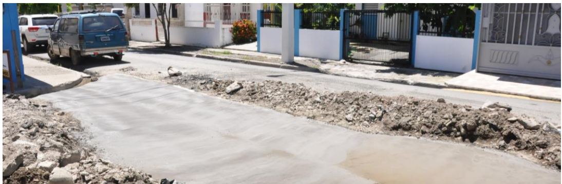
Construcción de badén en el barrio Nuevo Puerto Rico.
