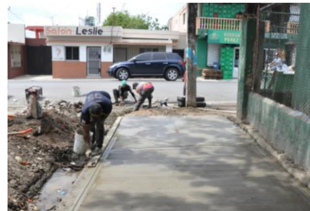
Construcción de acera en el Softball Club Eduardo Viñas.
