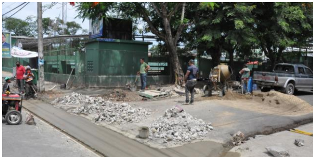
Construcción de badén en barrio José Horacio Rodríguez .
