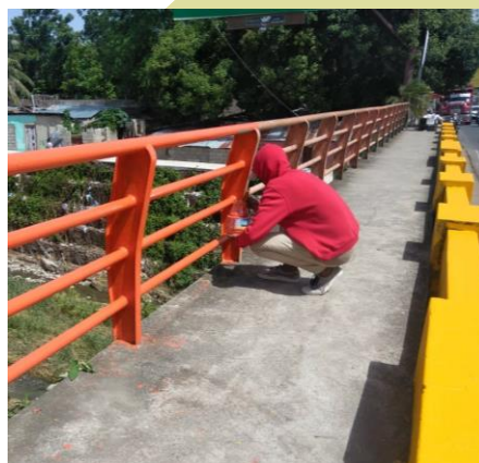
Mantenimiento puente de Juan Lopito.
